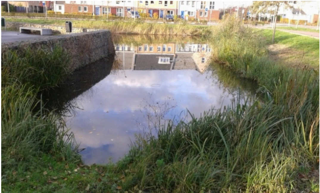
Figuur 2 Impressie oeverbescherming van schanskorven (linkerzijde foto)
