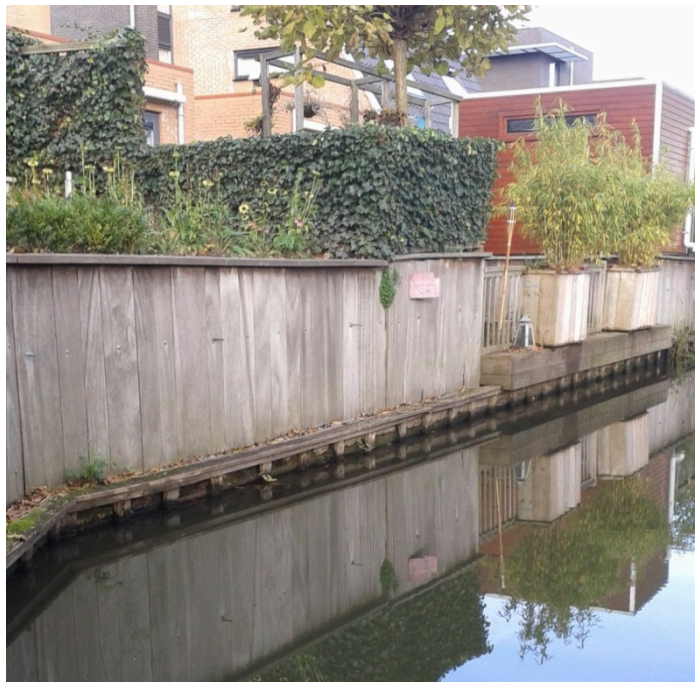
Figuur 9 Voorbeeld particuliere damwand achter projectmatig aangebrachte beschoeiing
